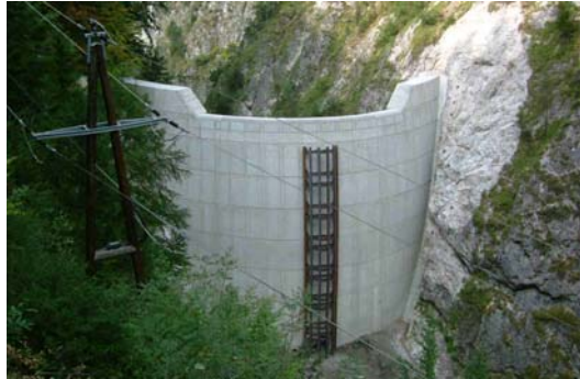
Abb. 3: Sperre Wörglerbach, Ansicht vom wasserseitigen Messpfeiler
